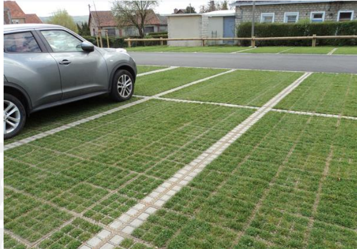
Figure 50 : Exemple de stationnement drainant
