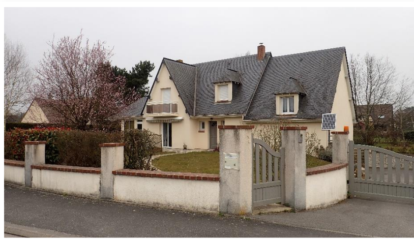
Figure 11 : Une majorité de logements construits dans les années 80 à 2000
