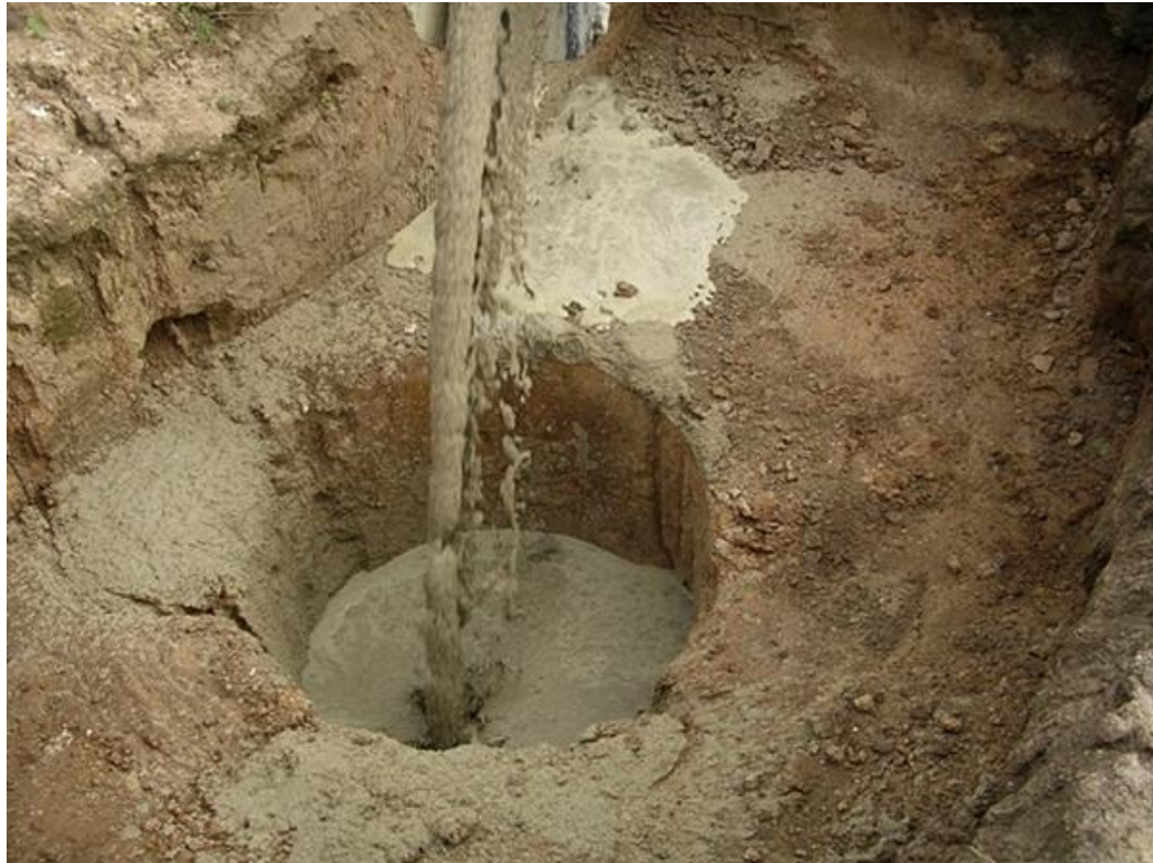
Figure 46 : comblement d'une marnière (Source : For & tech)
