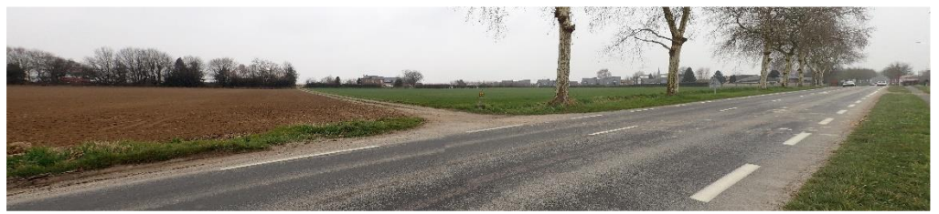
Figure 14 : La RD928 en direction du bourg (sud, 2016)
